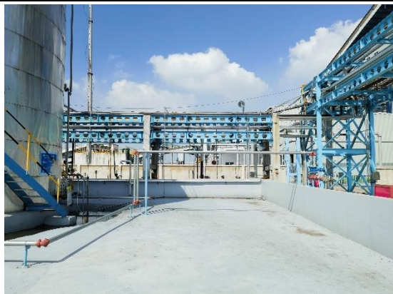
罐区防渗地面
