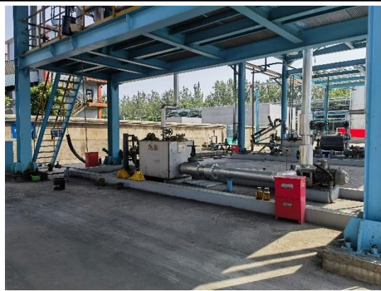
装卸站防渗地面
