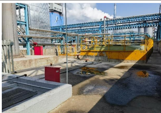
罐区污水收集池 300m 3
