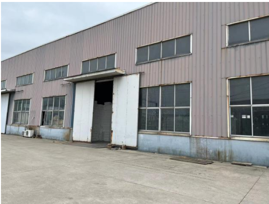
远东光电加工车间（变电站西侧）
