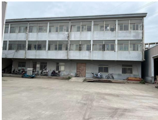
远东光电职工轮班宿舍（变电站西南侧）
