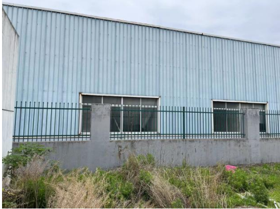
远东光电磨板车间（变电站东侧）
