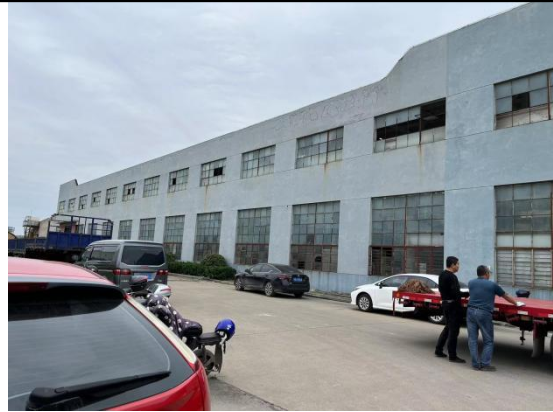
远东光电仓库（变电站南侧）
