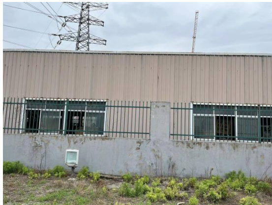
远东光电玻璃清洗车间（变电站北侧）
