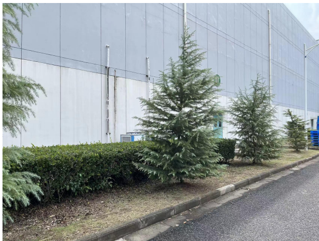
丙类成品仓库外部
