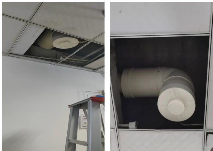
图 3-1 一期项目尾气燃烧炉+水喷淋装置拆除后现状
