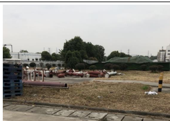
建设项目场地西面
